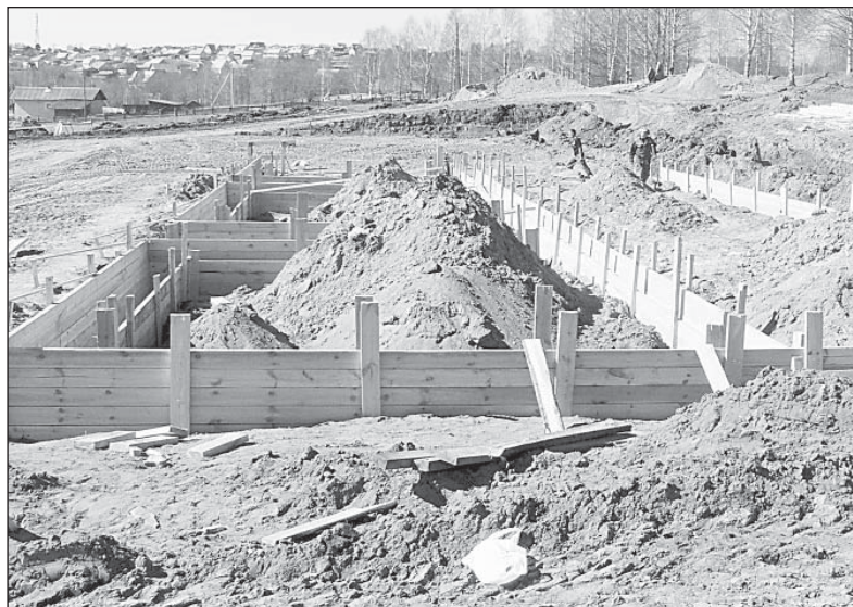
На Кошеве начали строить новый многоквартирный дом.
