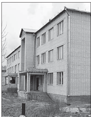
Здание предназначалось под профессиональное училище. Стрелительство начато в начале 90-х, на несколько лет стройка была заморожена. С 2000 года производились отдельные внутренние работы. Последние пять лет объект на консервации.
