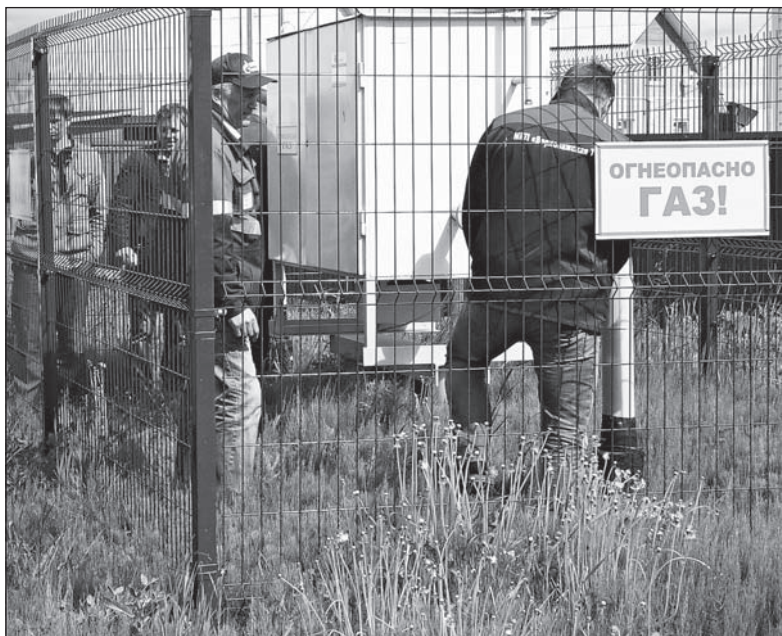
Идут пневматические испытания сетей на 4-м ГРП
