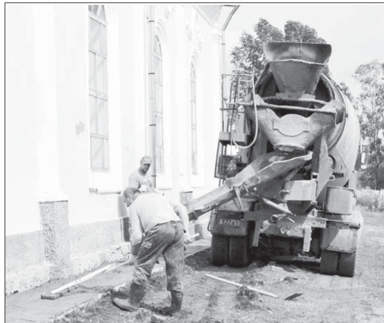
Идет ремонт отмостки у здания храма
