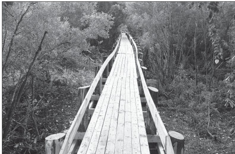
Протяженность новых мостков около 90 метров.
