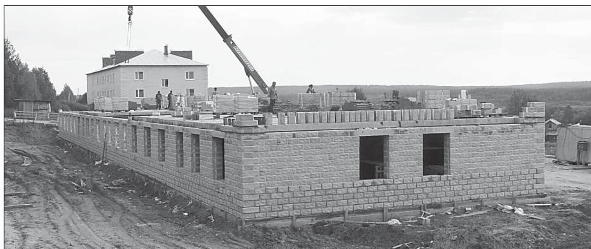
Начато строительство второго этажа.
