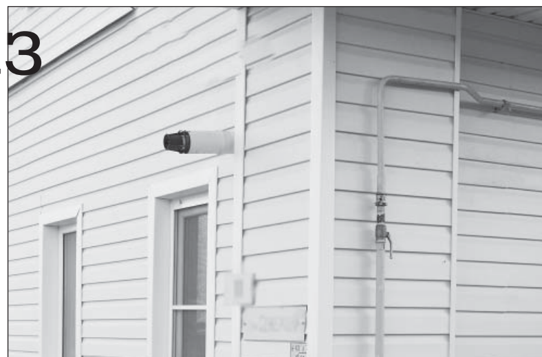
Аккуратно выполненная подводка газа не портит внешнего вида дома
