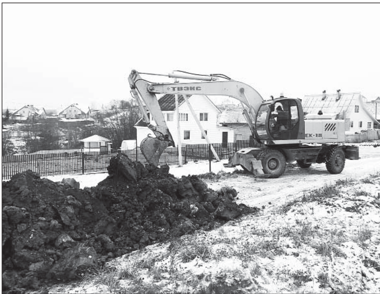
Бригада «Теплосети» ведет прокладку газопровода.
